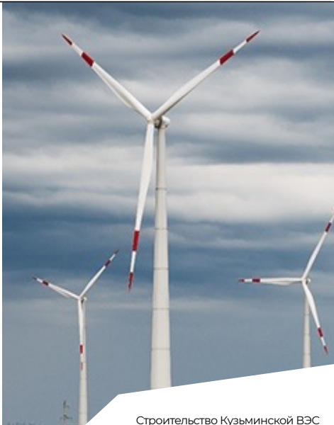
Строительство Кузьминской ВЭС (АО «ВетроОГК-2»)
