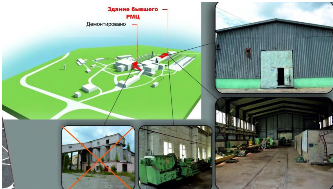
Здание бывшего ремонтно-механический цеха, S 890,4 м2; h 6 м.
